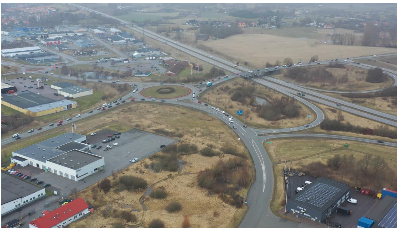
Figur 57: Väg 108 vid Trafikplats Svedala, vy åt väster. Fotot är taget under eftermiddagens rusningstrafik med långa köer för biltrafiken vid trafikplatsen. Vid detta fototillfälle har köerna p.g.a. bomfällningen sträckt sig hela vägen fram till trafikplatsen.
