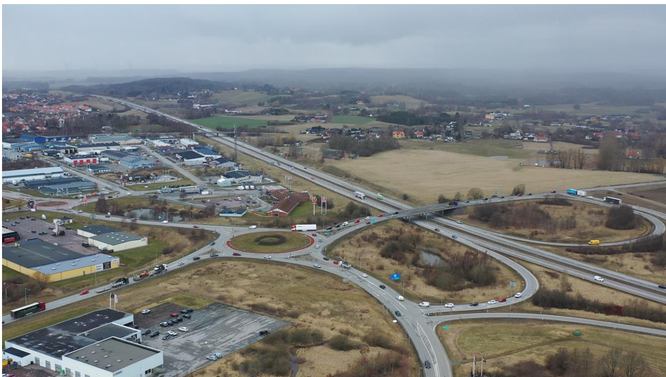
Figur 56: Väg 108 vid Tpl Svedala, vy åt väster. Fotot är taget under eftermiddagens rusningstrafik med bl.a. köer på bägge avfartsramperna från E65. Dessa köer är inte en följd av bomfällning, utan dessa köer uppstår p.g.a. flaskhalsar vid trafikplatsen. Korsningen mellan väg 108 och de norra ramperna utgör en trafiksäkerhetsbrist, då det bland annat saknas vänstersvängsfält på väg 108.
