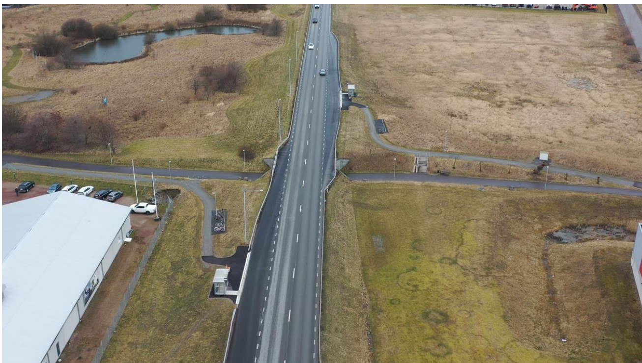
Figur 90: Väg 108 åt norr, strax norr om cirkulationsplatsen med Dalbyvägen. Hållplatslägena i båda riktningar på väg 108 syns bland annat i bild.
