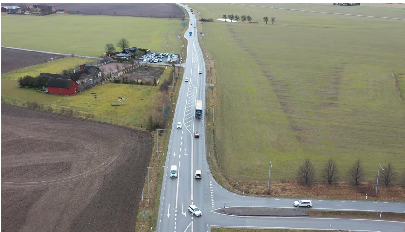
Figur 81: Väg 108 vid den södra korsningen med ramperna med väg 11, vy åt söder.
