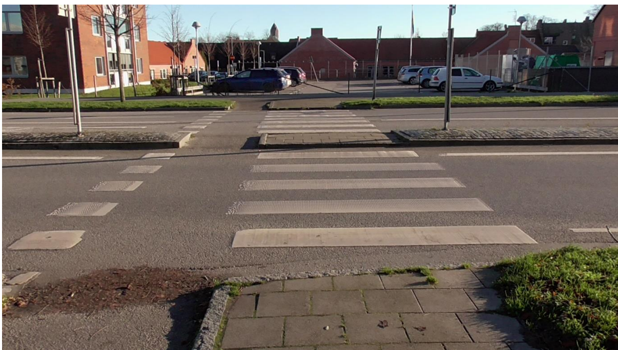
Figur 29: Övergångsställe med cykelpassage över väg 8 vid korsningspunkt 6. Liknande utformning av passager över väg 108 finns i korsning 7 och 8 samt över flera anslutande vägar. Vissa kantstenar är inte vinkelräta mot passagens riktning vilket kan vilseleda synskadade. Övergångsställena är inte signalreglerade eller hastighetssäkrade. Mittrefugerna är generellt cirka en meter breda och rymmer inte en cykel eller person med barnvagn. Rullstolar behöver generellt köras på cykelpassagen på grund av kantsten vid gångbanan. Det finns inga ledstråk för synskadade.
