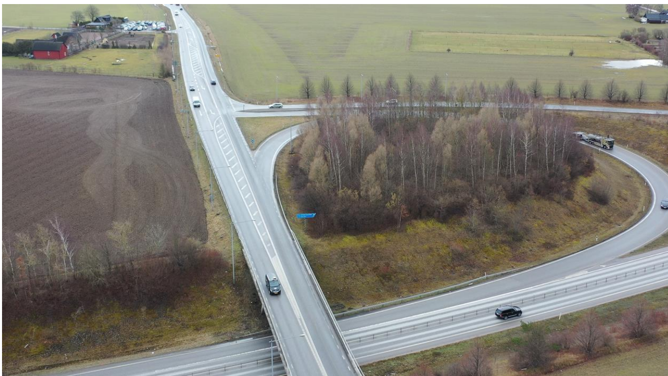
Figur 83: Väg 108 vid den södra korsningen med ramperna med väg 11, vy åt söder.
