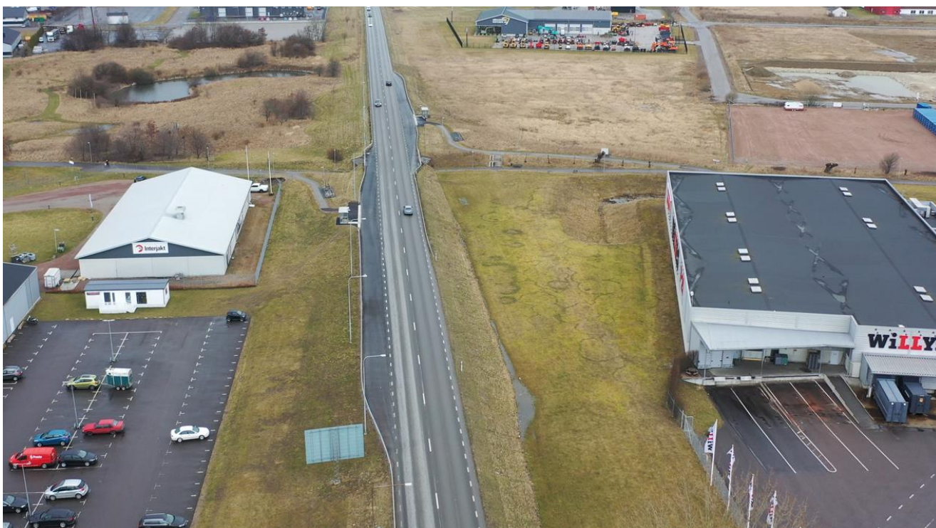
Figur 89: Väg 108 åt norr, strax norr om cirkulationsplatsen med Dalbyvägen. Det södergående hållplatsläget på väg 108 syns bland annat i bild.
