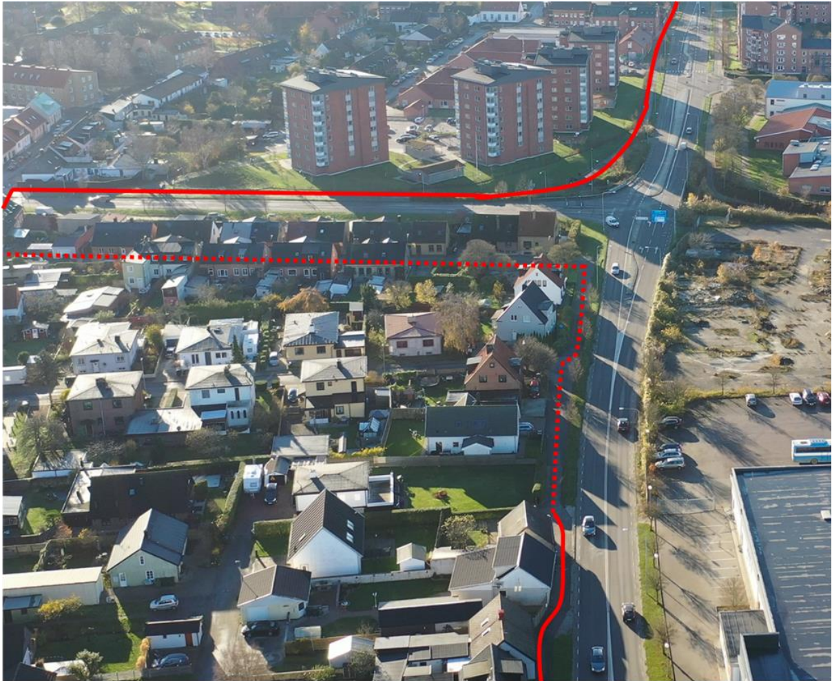
Figur 26: Cykelvägen markerad i rött, streckad väg avser blandtrafik med motorfordon. Bild tagen norrifrån och visar Allén som ansluter österifrån till väg 108. Cyklister längs med väg 108 tvingas göra en snäv sväng in på Fanjunkaregatan för att korsa Allén och sedan återgå till cykelbanan längs väg 108. Vägvisningen är dessutom bristfällig.
