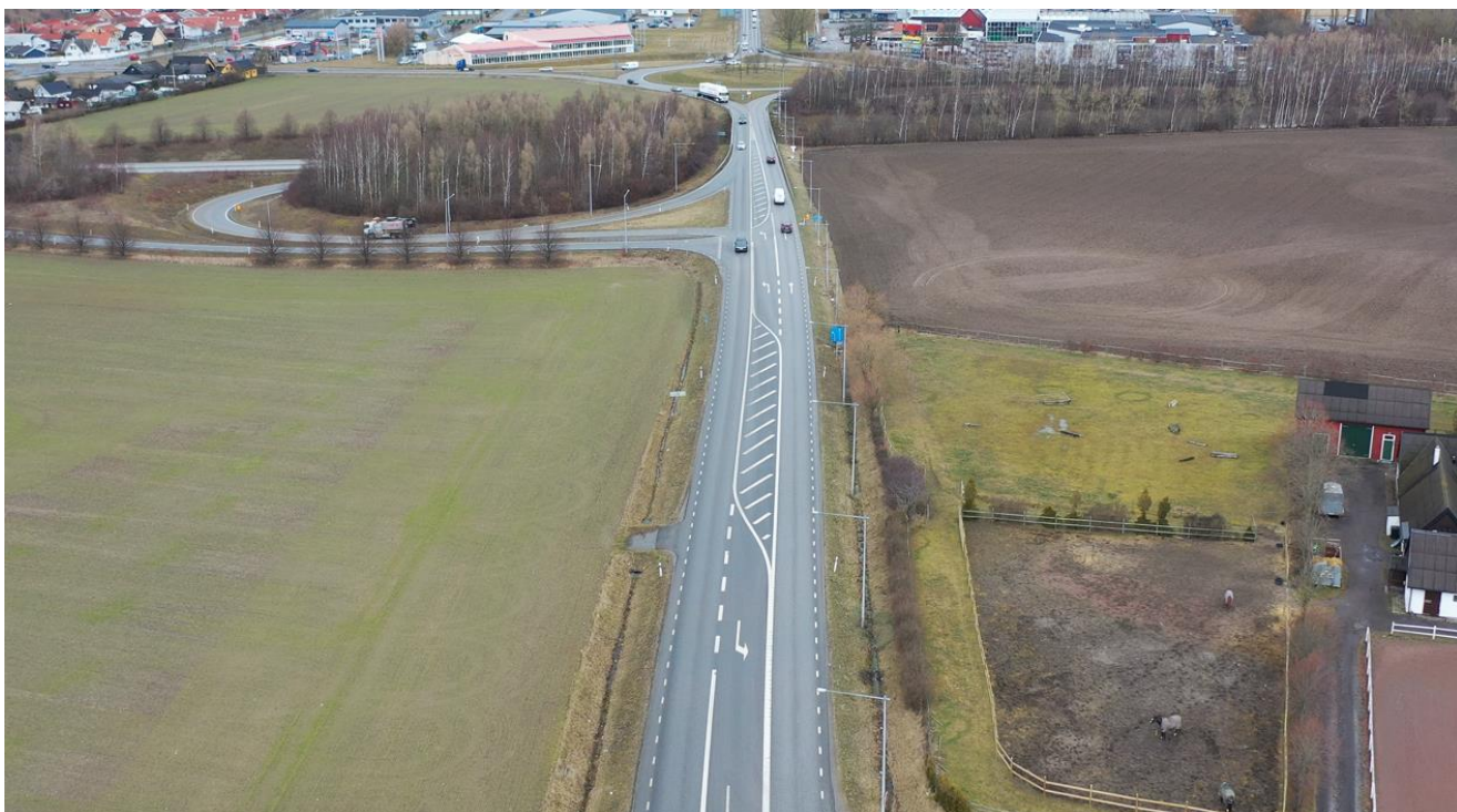
Figur 10: Väg 108 åt norr, på väg in i Staffanstorp. Korsningen med de södra ramperna i trafikplatsen syns i bild och längre norrut cirkulationsplatsen med Dalbyvägen.
