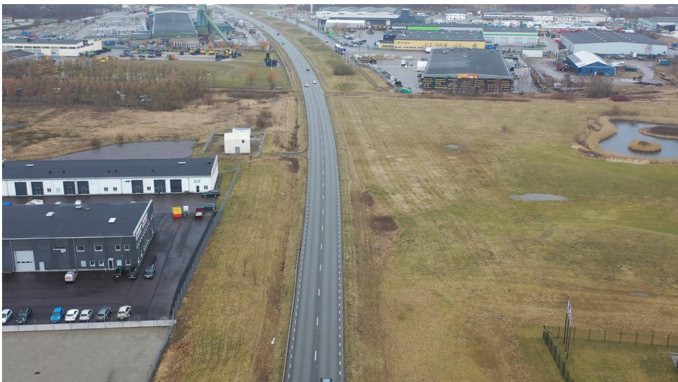
Figur 100: Väg 108 åt norr, mittför Staffanstorp (mellan cirkulationsplatserna med Dalbyvägen i söder och Gullåkravägen i norr).
