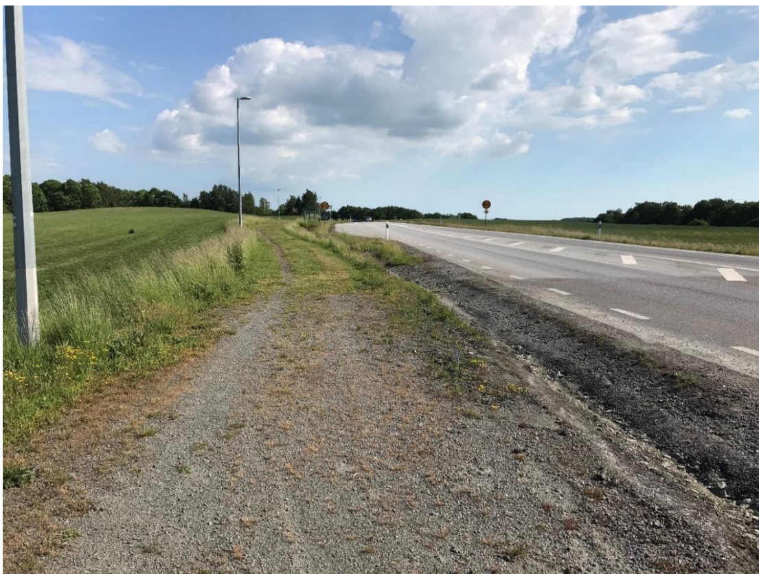
Figur 73: Bilden är tagen strax söder om cirkulationsplatsen vid Norra Sturupsvägen, i riktning söderut mot busshållplatsen Holmeja, på den östra sidan av väg 108.
