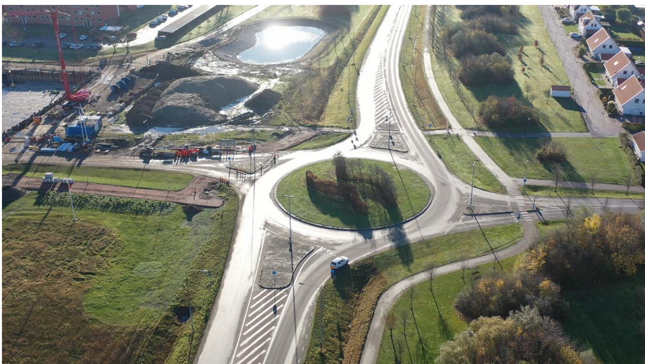
Figur 22: Väg 108 vid Havrejordsvägen, vy åt söder.
