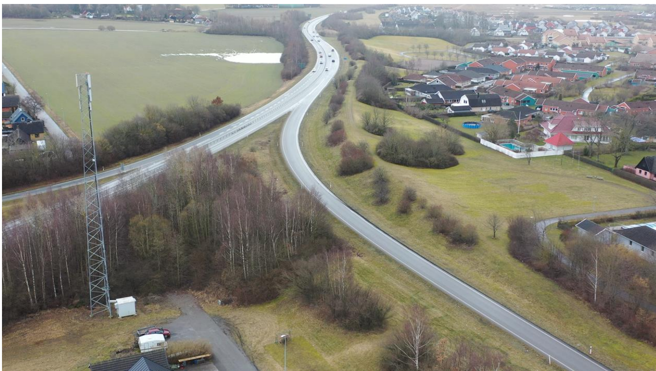
Figur 87: Vy västerut längs påfartsrampen mot väg 11 västerut. Även väg 11 åt väster syns i bild.
