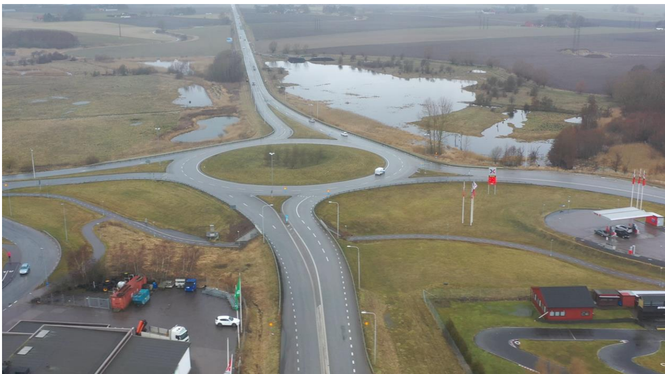
Figur 104: Väg 108 åt norr, vid cirkulationen med Gullåkravägen. Här slutar studiens utredningsområde. På sträckan mellan Staffanstorp och Lund kommer vägen byggas ut till fyrfältsväg någon gång under åren 2023-2027.
