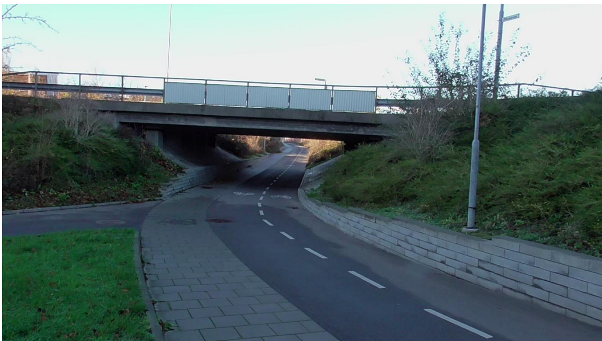
Figur 28: Planskild gång- och cykelpassage vid korsning 5. Bilden är tagen västerut. Väg 108 löper över bron och Allén ansluter uppe till höger i bild. Det finns gång- och cykelkopplingar åt söder, väster och öster, men inte norrut längs väg 108.
