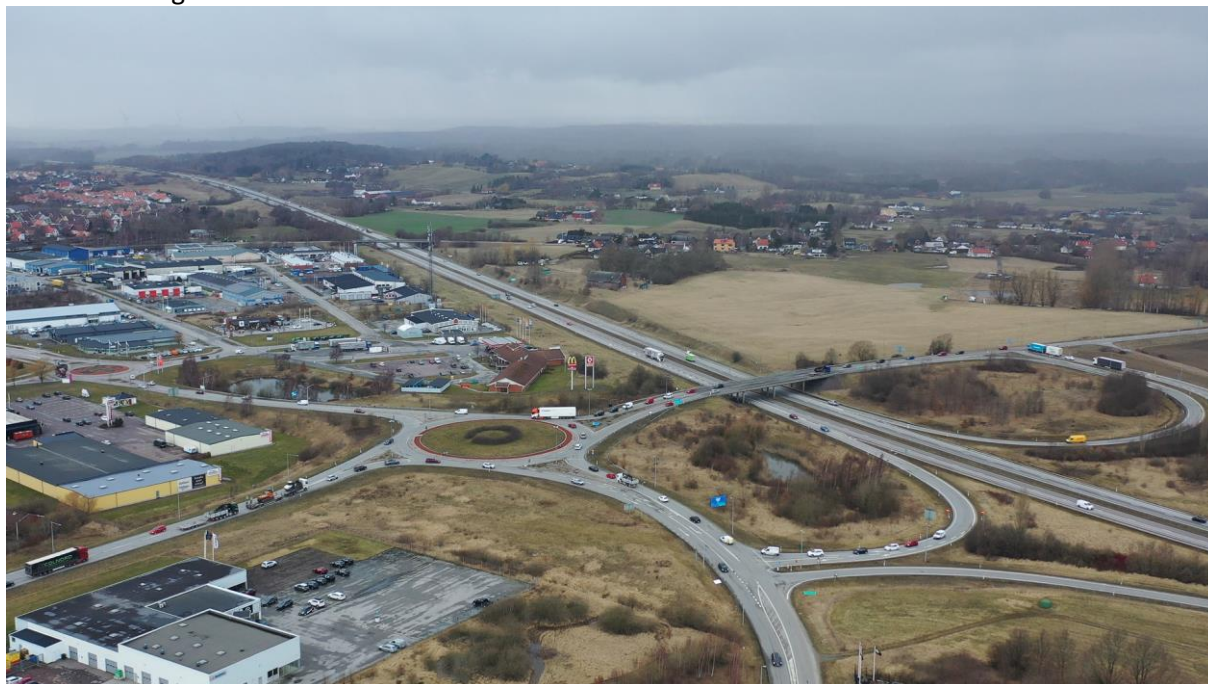
Figur 64: Typisk situation under eftermiddagens rusningsperiod, foto från drönaren under platsbesöket den 15 mars 2021. Köer fram mot den stora cirkulationen, som även fortplantar sig bakåt, bla ut på bägge avfartsramperna. Det har kontrollerats att dessa köer inte beror på flaskhalsen vid plankorsningen väg 108/Ystadbanan.
