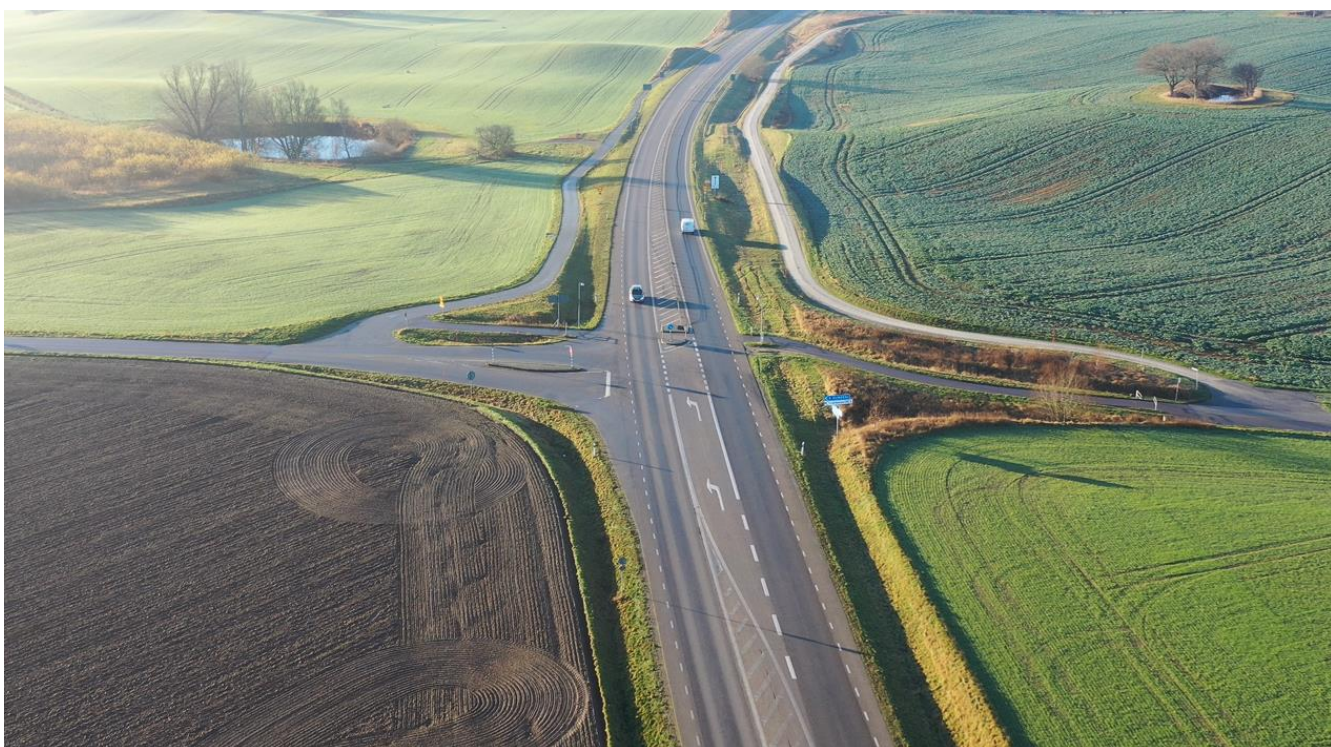
Figur 45: Väg 108 vid anslutning med Elinedalsvägen mot väster och Aggarpsvägen mot öster (Svedala) vilken endast kan anslutas med cykel/gång, vy åt söder.
