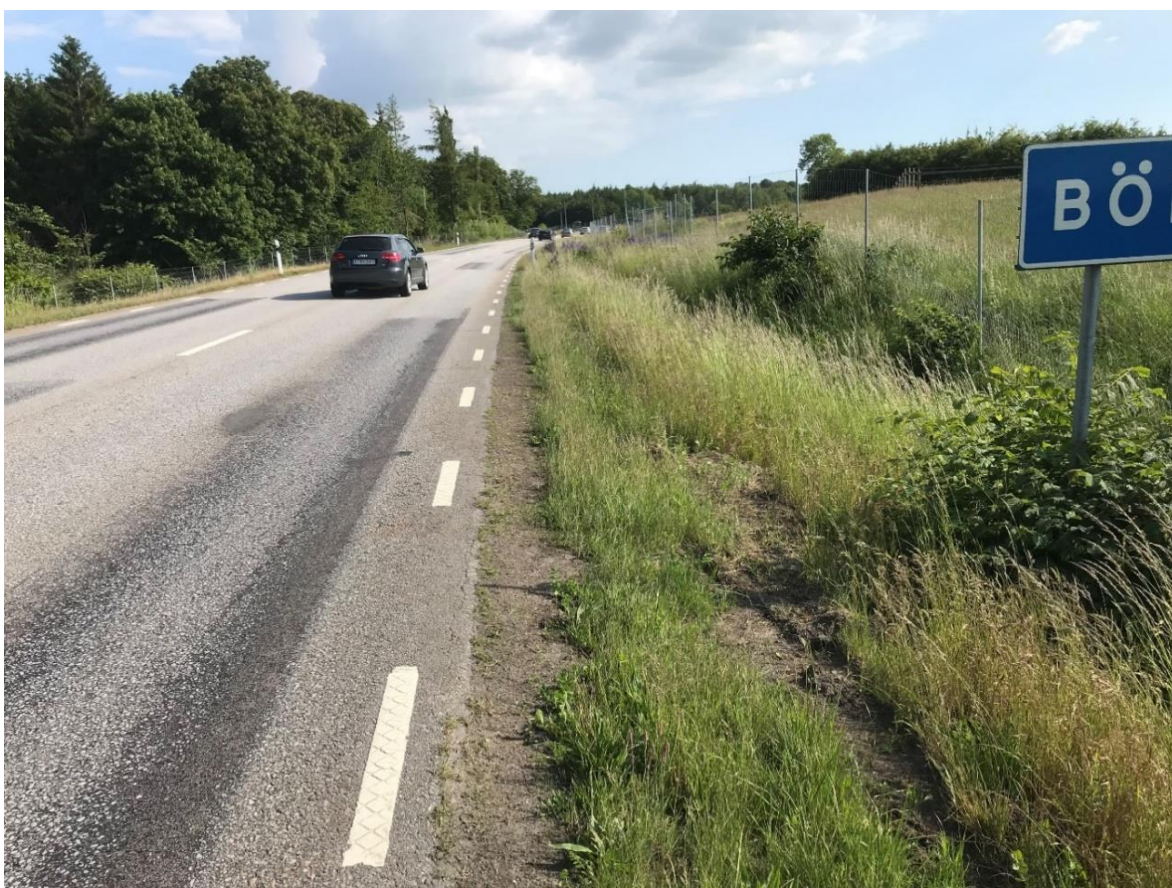
Figur 71: Väg 108 mellan Fjälltofta och Bökebergsvägen. På detta avsnitt finns inget parallellt gent nät lämpligt för cykling i blandtrafik utan cyklister hänvisas till väg 108. Det finns ingen vägren att cykla på.
