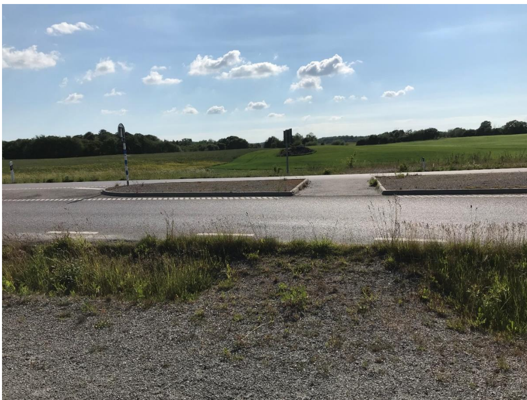
Figur 75: Cirkulationsplatsen vid Norra Sturupsvägen. Det finns en refug som visar var fotgängare och cyklister ska korsa, men anslutande gång-och cykelväg har låg standard.
