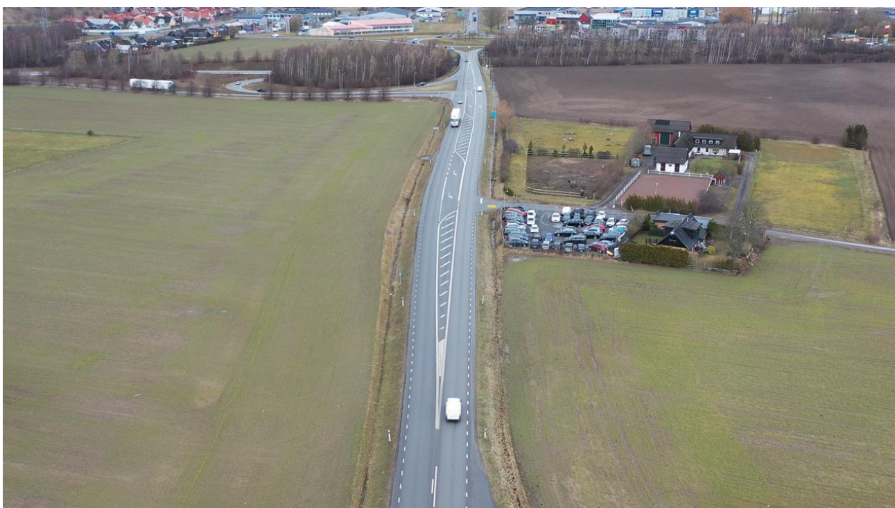
Figur 79: Väg 108 åt norr, på väg in i Staffanstorp. Korsningen med Flintevångsvägen syns i bild och lite längre norrut korsningen med de södra ramperna i trafikplatsen med väg 11.
