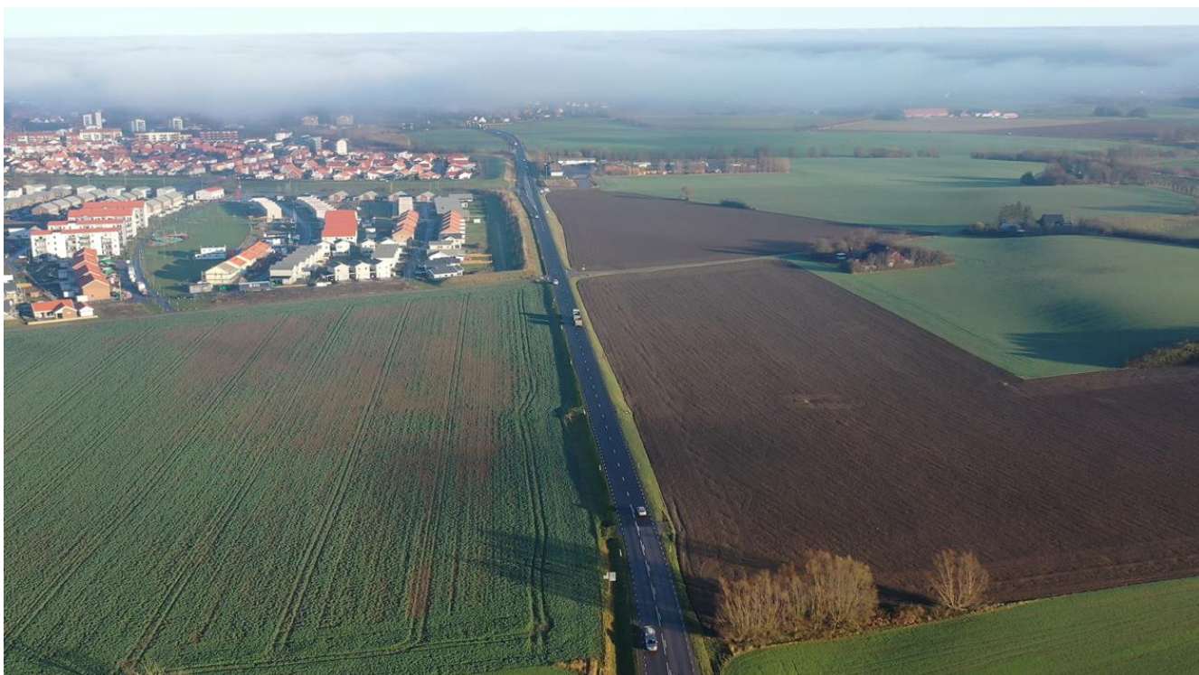
Figur 46: Väg 108 åt norr med Södra infarten i bakgrunden (fotot taget från i höjd med Aggarpsvägen).
